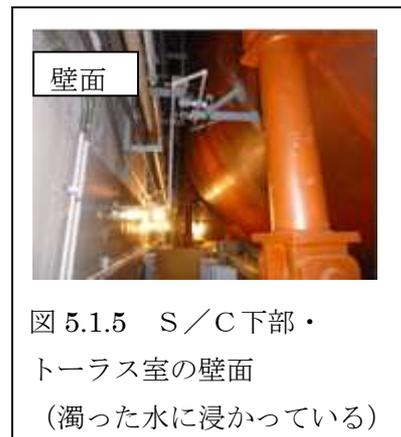
S/C 下部とトーラス室の壁面では水中に漏洩している水の流れを検出しなければならない。水の漏洩は、注水量5～6 m<sup>3</sup>/時間（おおよそ 15×15×15 cm/秒）と同じと推定される。1か所で漏洩している場合は、家庭の水道栓を大きく開けた程度である。漏洩検出方法についてはカメラによる目視だけでなく、いろいろな方法を検討する必要がある。
